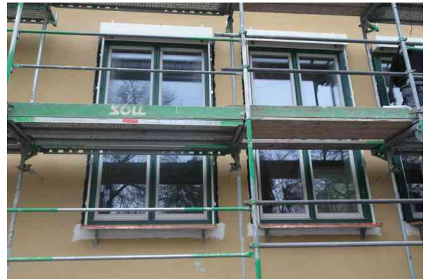
Baustelle, Quelle: EBB
